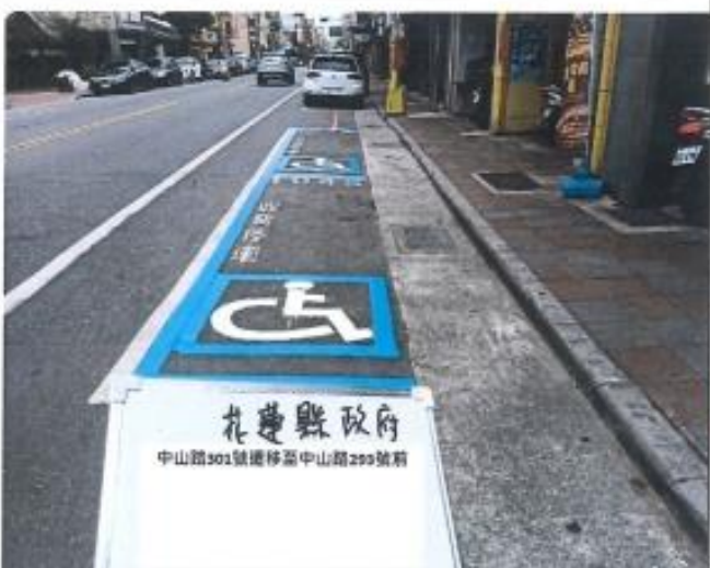
完工後-調整至路段中間(中山路 293 號前)
